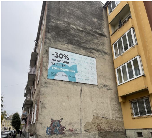
На фасаді буд.№4 вул.І.Мазепи
