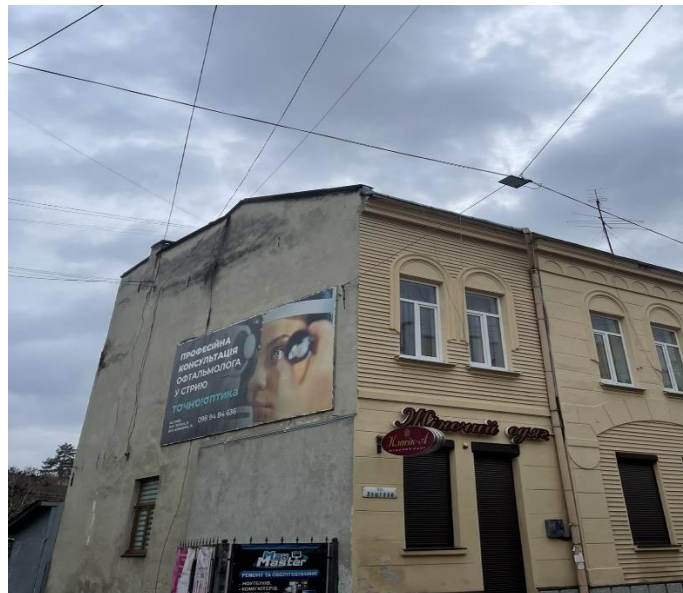
На фасаді буд.№14 вул.Поштова.
