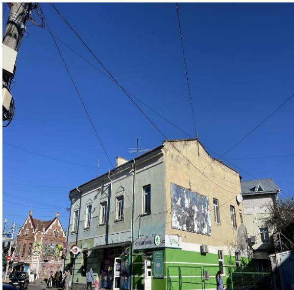
На фасаді буд.№38 вул.Успенська
