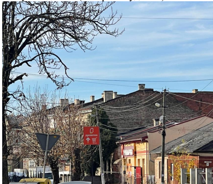
По вул. Підзамче (навпроти буд.№13)
