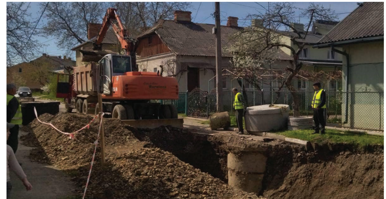
Рис.7 Заміна каналізаційного колектора На вулиці Кривій в м. Стрий за підтримки фонду ООН Юнісеф Джерело: Стрийська міська рада
