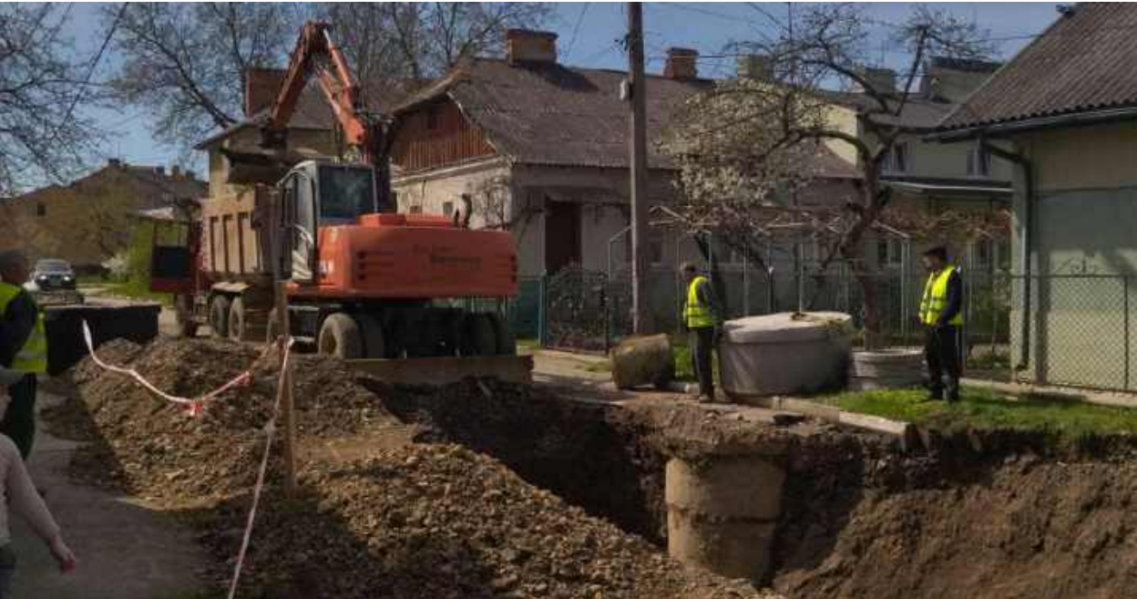
Рис. 34 Заміна каналізаційного колектора На вулиці Кривій в м. Стрий за підтримки фонду ООН Юнісеф Джерело: Стрийська міська рада
